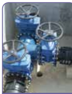
Centrale EDF de Martigues, France, Marseille, AquaGrip
