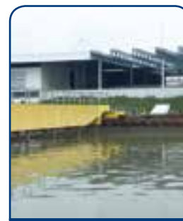
Usine de traitement des eaux usées, Lyon, France, grand diamètre
